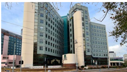
Budynek ZUS w Szczecinie ul. Matejki; konstrukcja nieregularny szkielet stalowy 9–10 kondygnacji nadziemnych
