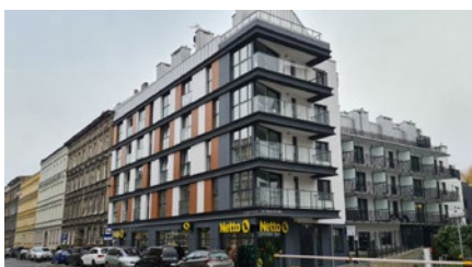
Budynek mieszkalno-usługowy w Szczecinie ul. Śląska; konstrukcja ścianowo-szkieletowa mieszana żelbetowo-murowana
