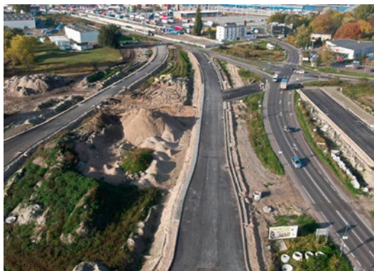
Na obu zdjęciach budowa dróg dojazdowych/wyjazdowych z tunelu po stronie wyspy Wolin. Drogi te będą łączyły się z S3 fot. UM Świnoujście/Sweco
