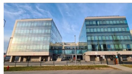
Budynki biurowe ul. Południowa w Szczecinie; konstrukcja płyto-słupowo-ścianowa żelbetowa
