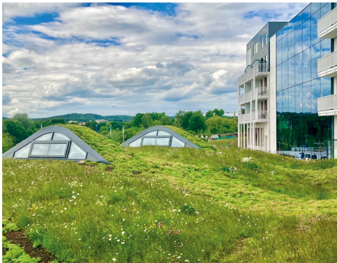
Radisson Blu w Sopocie – dach zielony z rozchodnikami i kwietną łąką nad częścią konferencyjną hotelu
